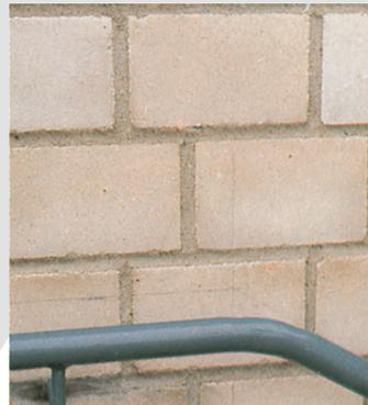
**Außen:** Kalksandstein-Außenmauerwerk sollte nach den Empfehlungen des BFS-Merkblattes Nr. 2 „Beschichtungen und Imprägnierungen auf Kalksandstein-Sichtmauerwerk“ nur mit Silikat- oder Siliconharz-Emulsionsfarben beschichtet werden. Wir empfehlen hierfür Sylitol® oder AmphiSilan-Fassadenfarben einzusetzen.
