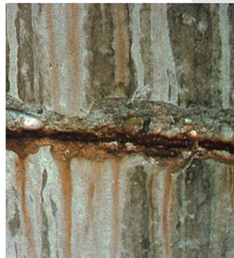
**Außen:** Zur Instandsetzung stark beschädigter Betonflächen mit Absprengungen und freiliegender Armierung empfehlen wir das Disbocret-System einzusetzen. Bitte fordern Sie die ausführlichen Unterlagen an.
