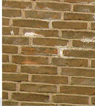
**Außen:** Nur frostbeständige Vormauersteine oder Klinker ohne Fremdeinschlüsse für Anstriche geeignet. Das Mauerwerk muß rissfrei verfugt und salzfrei sein.
