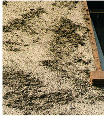
**Außen:** Mit geeigneter Methode unter Berücksichtigung der gesetzlichen Vorschriften entfernen. Mit Capatox bzw. bei saugenden Untergründen mit FungiGrund als gleichzeitige Grundbeschichtung durchwaschen und gut trocknen lassen.
