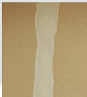
**Innen:** Spachtelgrate abschleifen. Geschliffene Gipsspachtelstellen sowie die Gipskartonplatten mit OptiSilan TiefGrund, CapaSol RapidGrund oder Sylitol RapidGrund 111 grundieren.
