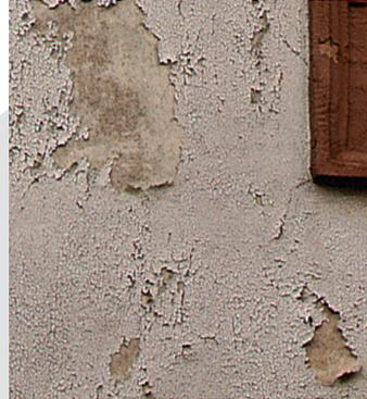
**Außen:** Restlos entfernen durch Abschleifen, Abschaben, Naßstrahlen oder andere geeignete Methoden. Bei Naßreinigung die Flächen vor der Weiterbehandlung gut durchtrocknen lassen.
