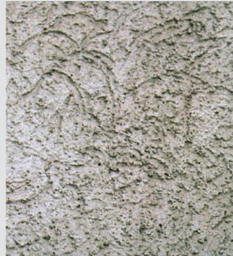
**Außen:** Alte Putze mit geeigneter Methode unter Beachtung der gesetzlichen Vorschriften reinigen. Bei NaBreinigung max. mit 60 bar Druck abstrahlen. Die Flächen vor der Weiterbehandlung gut durch-trocknen lassen.
