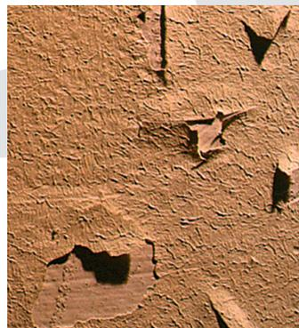
**Außen:** Restlos entfernen mit geeigneter Methode, z.B. mechanisch, oder durch Abbeizen und Nachreinigen durch Druckwasserstrahlen unter Beachtung der gesetzlichen Vorschriften. Bei Naßreinigung die Flächen vor der Weiterbehandlung gut durchtrocknen lassen.
